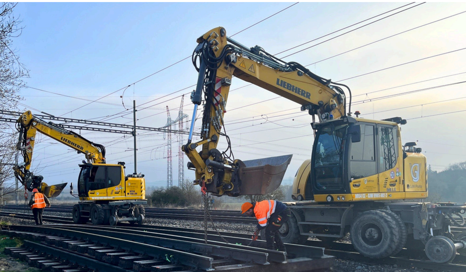
Dvoucestná rypadla LIEBHERR A922 Rail na stavbě Modernizace železničního uzlu Česká Třebová
